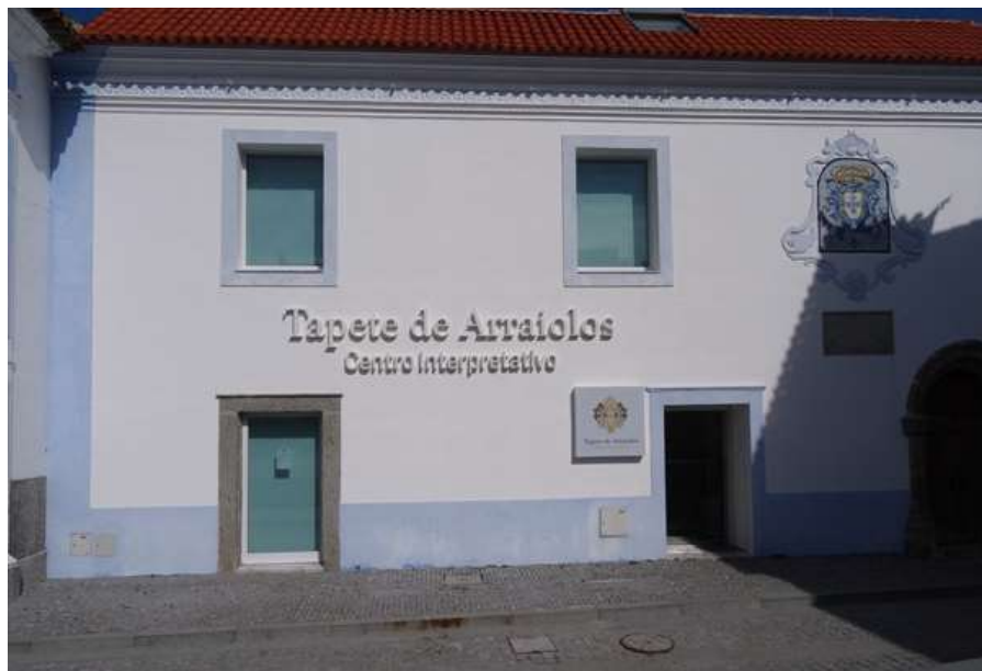
Figura 72 – Centro Interpretativo do Tapete de Arraiolos
